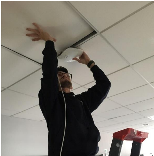
Figure 23 et 24 : Installation de la borne Wi-Fi
