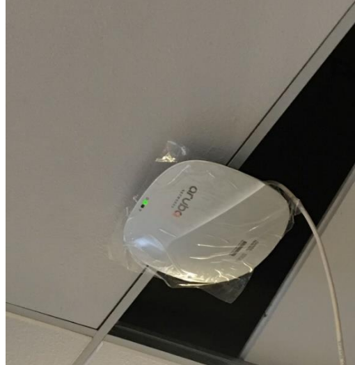
Figure 23 et 24 : Installation de la borne Wi-Fi
