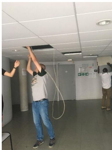
Figure 25 : Passage du câble dans le faux plafond
